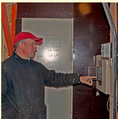
Axel Lagerfelt inne i torkanläggningen på Tolefors Gård. Foto: P.F.
